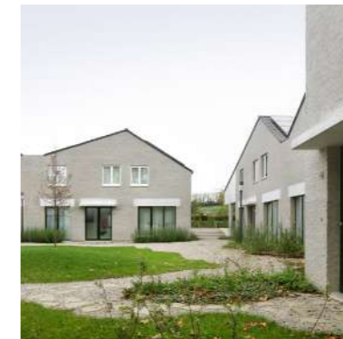
FIGUUR 54: (Links) DVC Zevenbergen te Ranst ontworpen door NU Architectuur Atelier (2023). Het concept voor ontwerp is gebaseerd op de meerwaarde van samenleven met een kwalitatieve collectieve leefomgeving met bewegingsvrijheid.
