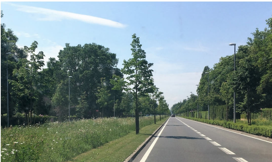
Figuur: aangepast maaibeheer. Een netheidsboord wordt frequent gemaaid, terwijl het centrale deel van de berm slechts 2x per jaar gemaaid wordt (met afvoer) waardoor die bloemrijker, soortenrijker en waardevoller wordt (zowel naar natuur als naar ESD). Als de bomen in de netheidsboord zelf staan (zoals op de foto het geval is) kan een verbetering eruit bestaan om rond de bomen zelf een zone van 0,5 tot 1m rond de stam slechts 1x per jaar te beheren.
